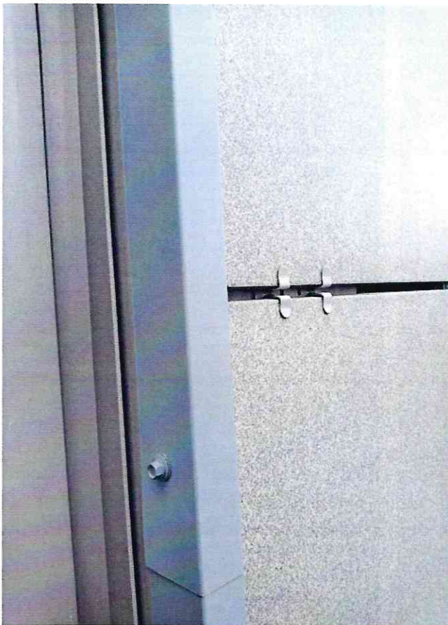
Пример монтажа прижимных планок
